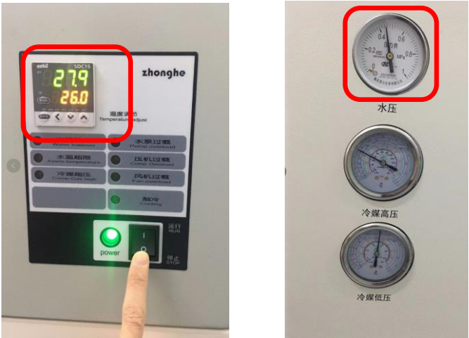
图 6-6 水冷机温度及水压示意图
