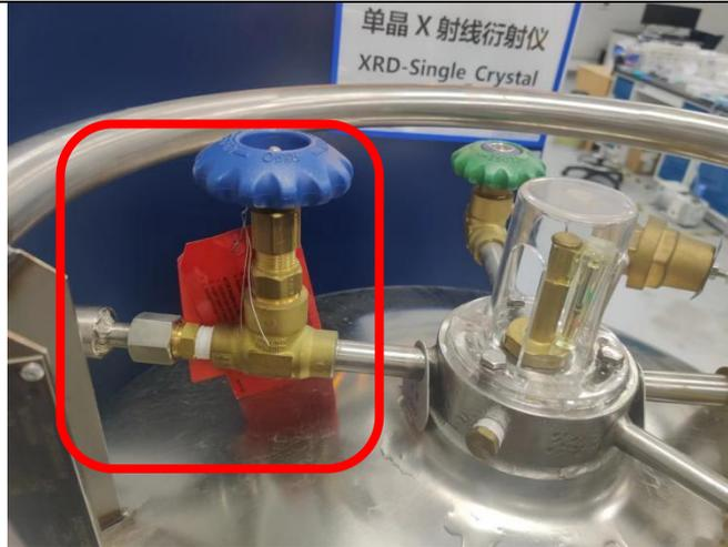
Figure 3. 大液氮罐的液体阀门
